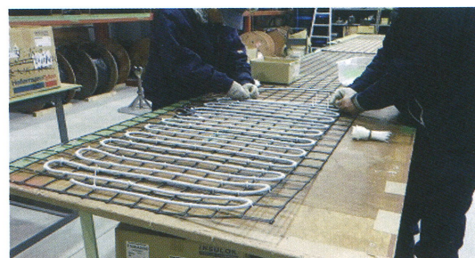
写真－43 ロードヒーティング製作
