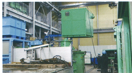
写真-35 荷降ろし作業（排泥ユニット）
