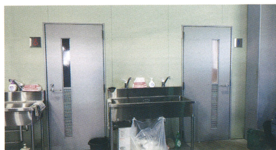
写真-11 C棟 男女温水洗浄式トイレ
