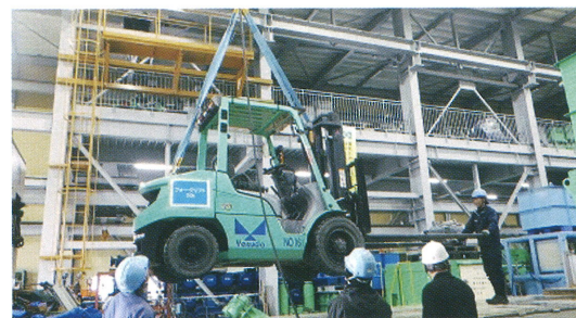
写真-36 荷降ろし作業（3tフォークリフト）
