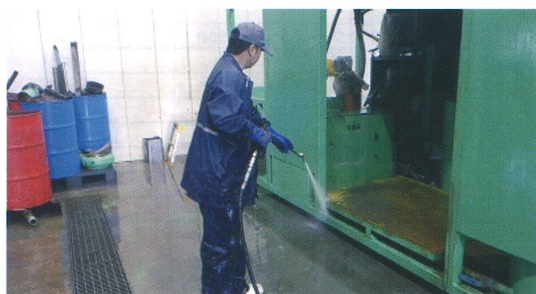
写真-26 送泥プラント洗浄作業
