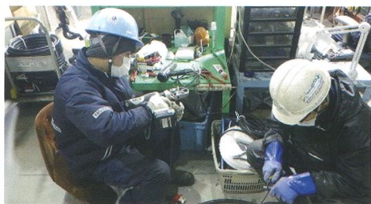
写真-37 動力線の修理作業
