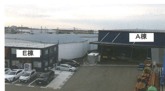
写真-2 A棟およびE棟
