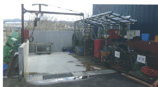
写真－19 C・D棟間にある奥の洗い場
