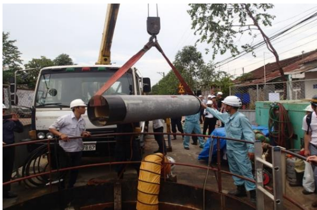
ベトナムでの工事見学会の様子
